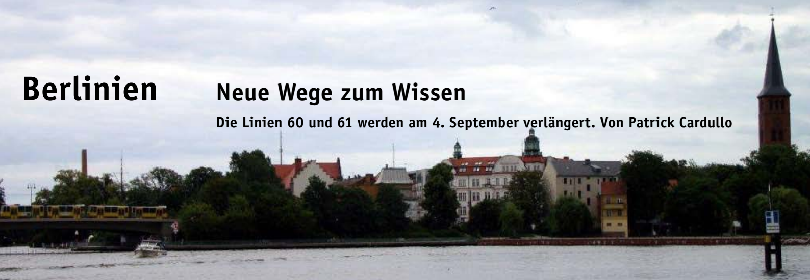
Blick auf die Köpenicker Dammbrücke – rechts das Rathaus
